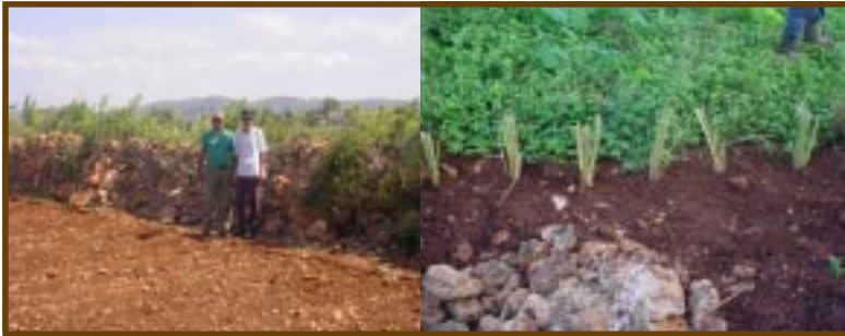
Foto 19. Empleo de barreras de piedras y Vetiver para evitar erosión
